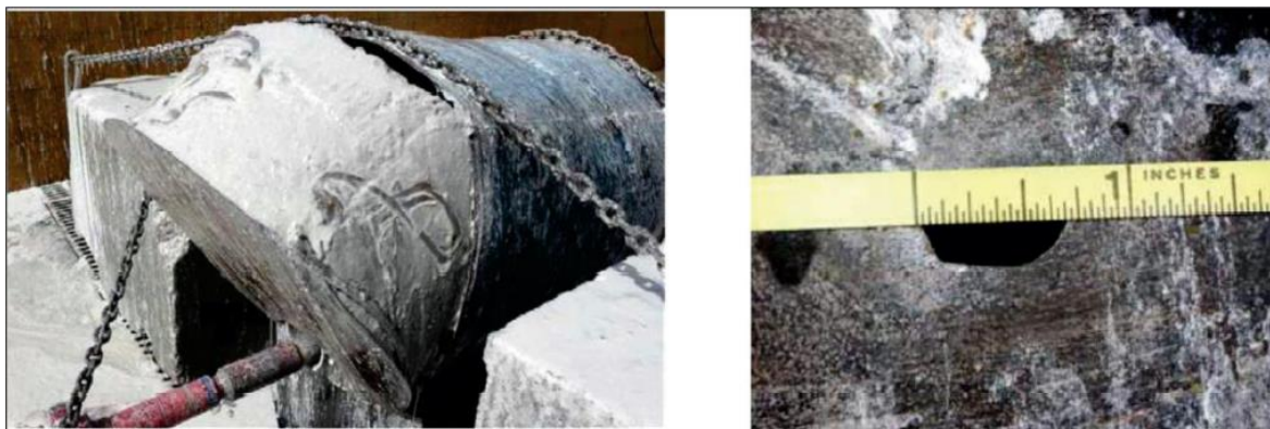
Zona inelară de ciment fisurată după Aplicarea soluției acide abrazive cu hidrojetul
