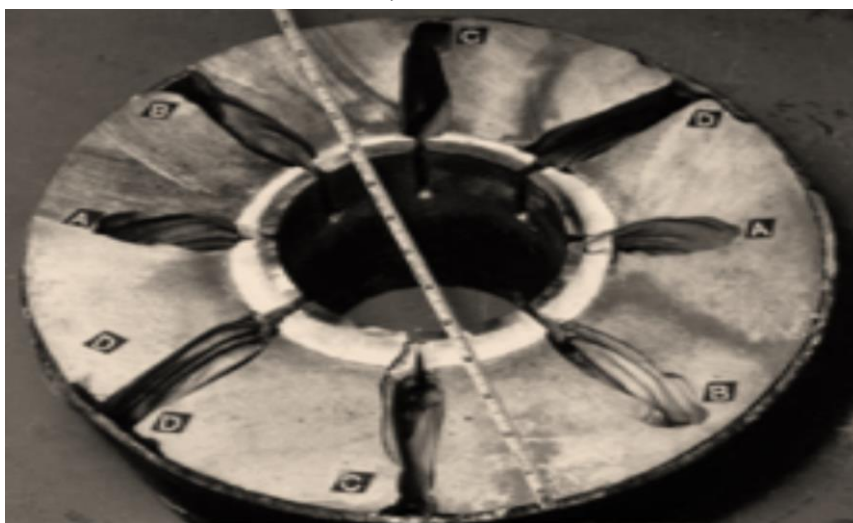
Zona inelară de ciment fisurată după Aplicarea soluției acide abrazive cu hidrojetul
